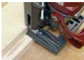
Fresado de Rebajos
