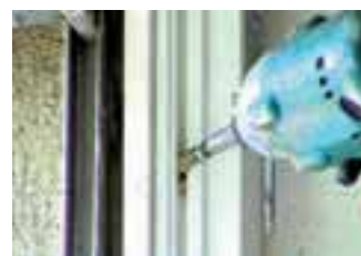
4. Montar la nueva ventana
