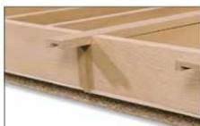
La colocación de la regleta de unión es necesaria siempre que el interior del cajón contenga más de un elemento.
